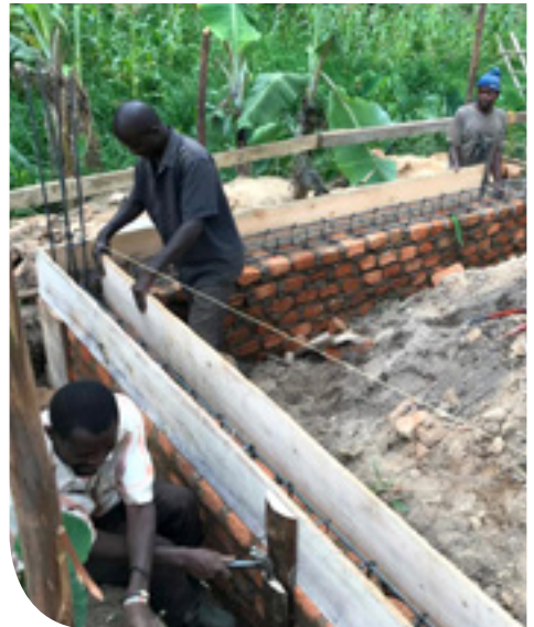
Nach einer Woche wird bereits gemauert
