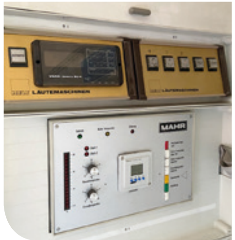
Anlage zur Steuerung vom Geläut und der Stundenglocke
